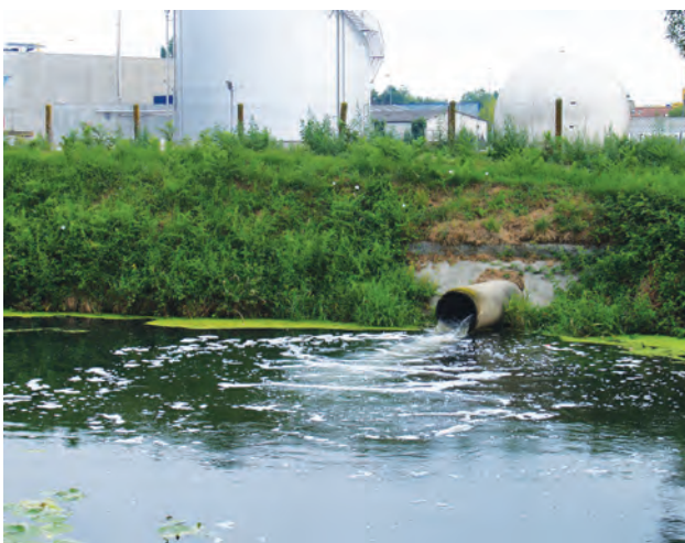
Exutoire d'une station de traitement des eaux au milieu naturel
