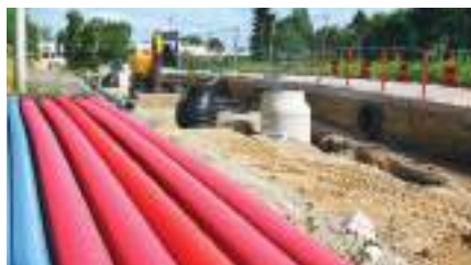
Plate-forme d'intervention à proximité des réseaux
