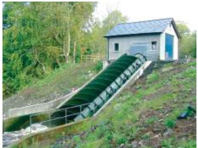
Microcentrale hydroélectrique à vis d'archimède
