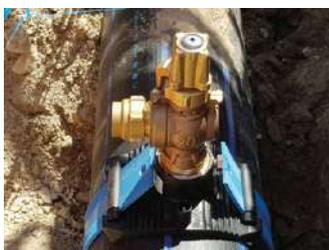
Innovant, OMEGAFLEX est un collier de prise en charge électrosoudable multidiamètre qui permet des gains logistiques et
