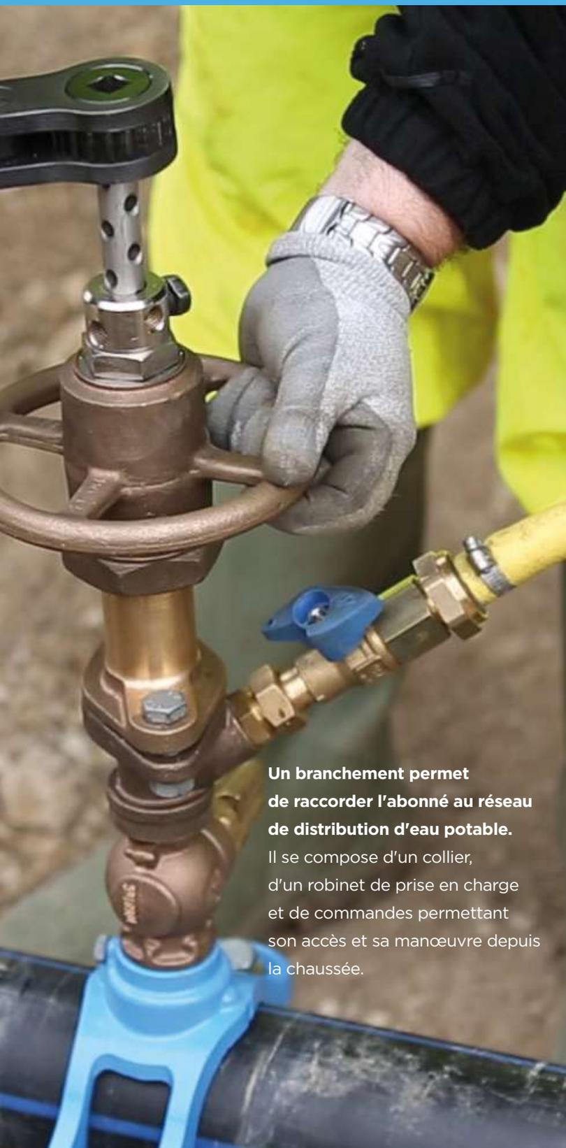
**Un branchement permet de raccorder l'abonné au réseau de distribution d'eau potable.**
