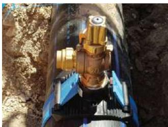
Innovant, OMEGAFLEX est un robinet-collier de prise en charge électrosoudable multidiamètre qui permet des gains logistiques
