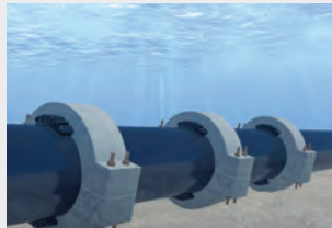
Buter les éléments de lestage d'un tube
