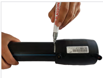
4 Mesurer et marquer le bon positionnement des pièces à l'aide d'un marqueur PE.
