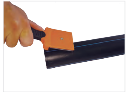
3 Gratter le tube sur toute la surface de soudage à l'aide d'un racleur manuel ou d'un racleur mécanique.
