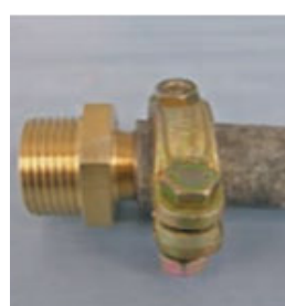
Ramener le collier et le serrer à 3 mm du bord du plomb.
