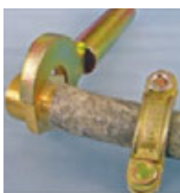
Bloquer le raccord en allant au-delà du premier serrage (Collier toujours en retrait).
