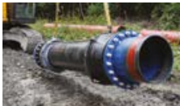
Raccord Géoflex en cours d'installation sur la conduite forcée de la centrale hydro électrique des Encombres, en Savoie
