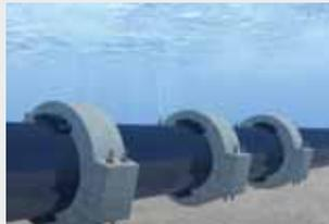
Buter les éléments de lestage d'un tube
