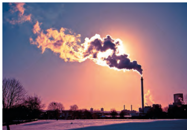
Unité de traitement thermique.
