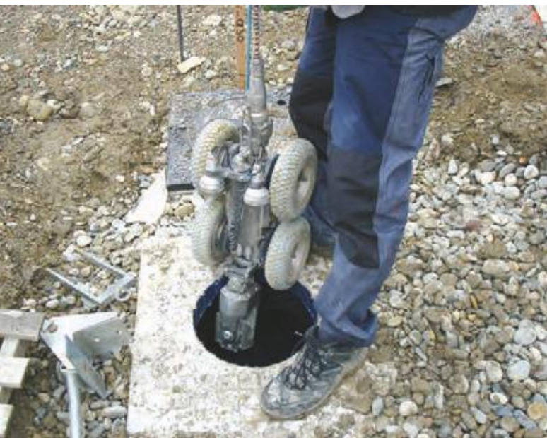
Inspection télévisée sur réseau d'entraînement.
