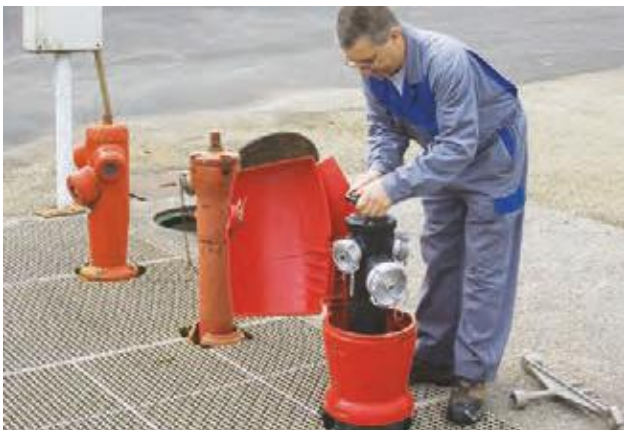
Maintenance des bouches d'incendie.
