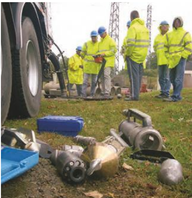
Travaux pratiques d'hydrocurage.
