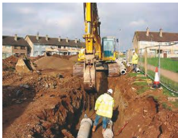
Mise en œuvre d'un chantier de pose de réseaux d'assainissement.
