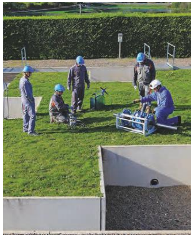
Travaux pratiques d'électrosoudage de tube polyéthylène.
