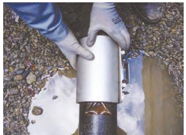
Travaux pratiques de réparation de fuite sur réseau.
