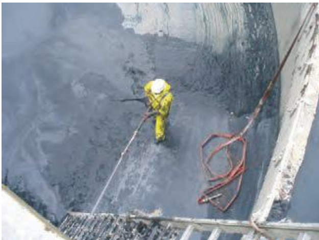
Opération d'entretien sur bassin.
