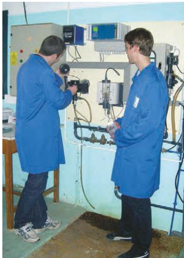
Travaux pratiques d'exploitation et d'entretien de capteurs.
