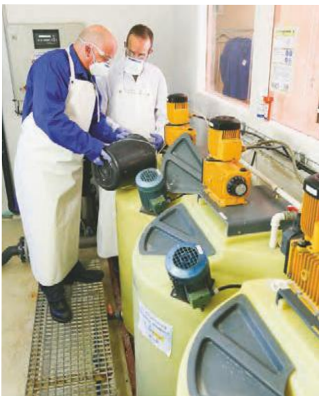
Préparation de réactif par bâchée.
