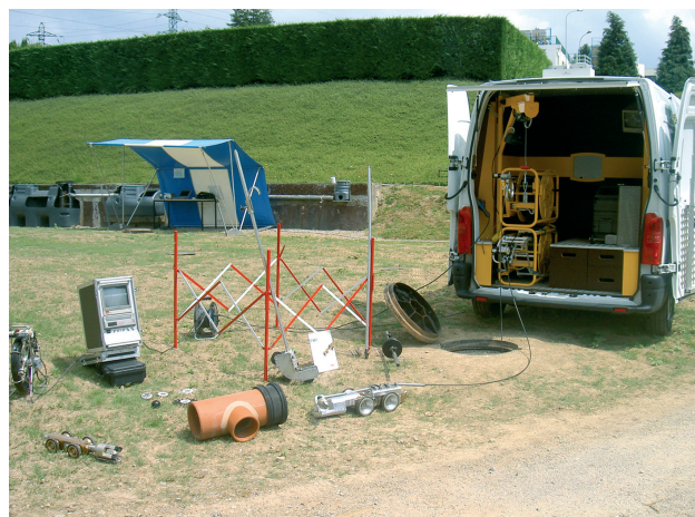
Inspection télévisée sur réseau d'entraînement.
